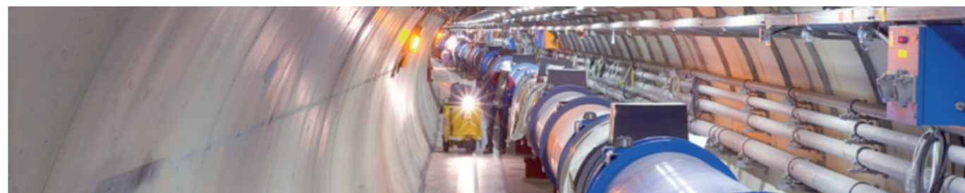
LHC Large Hadron Collider. È costruito all’interno di un tunnel sotterraneo lungo 27 km situato presso il CERN di Ginevra
